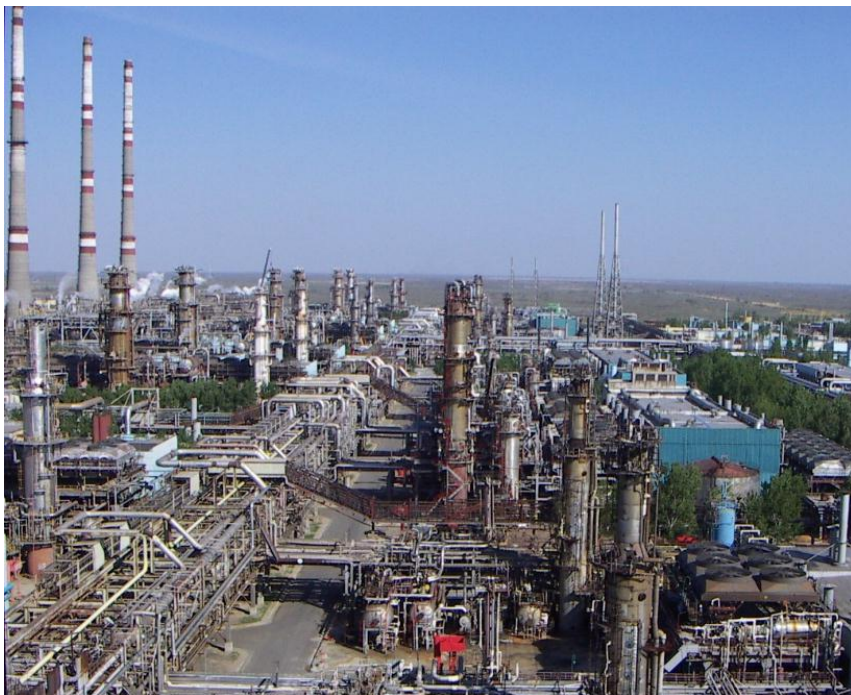
Рис. 1. Абсорбционные установки для улавливания сероводорода на газоперерабатывающем заводе
