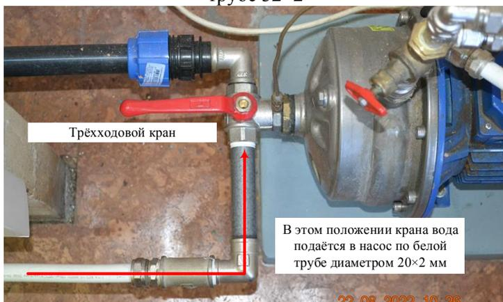
Рис. 3-а. В этом положении трёхходового крана вода поступает в насос по трубе 20×2
