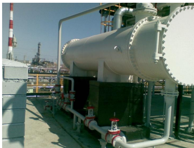
Рис. 8. Двух- и более ходовые кожухотрубчатые теплообменники
