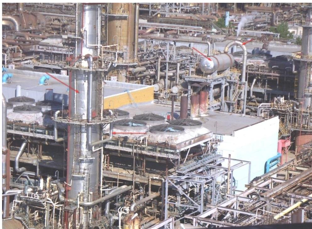
Рис. 16.1. Тепловая изоляция колонн, теплообменников и трубопроводов газоперерабатывающего завода
