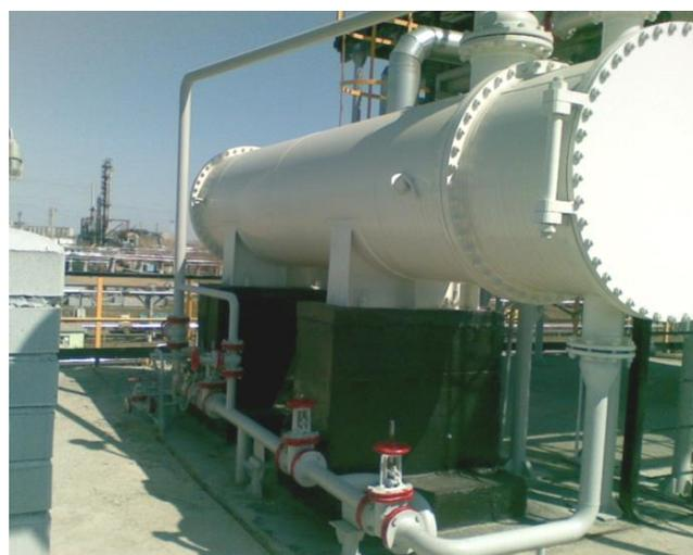
*Рис. 2.9. Фотографии двух- и более ходовых кожухотрубчатых теплообменников*
