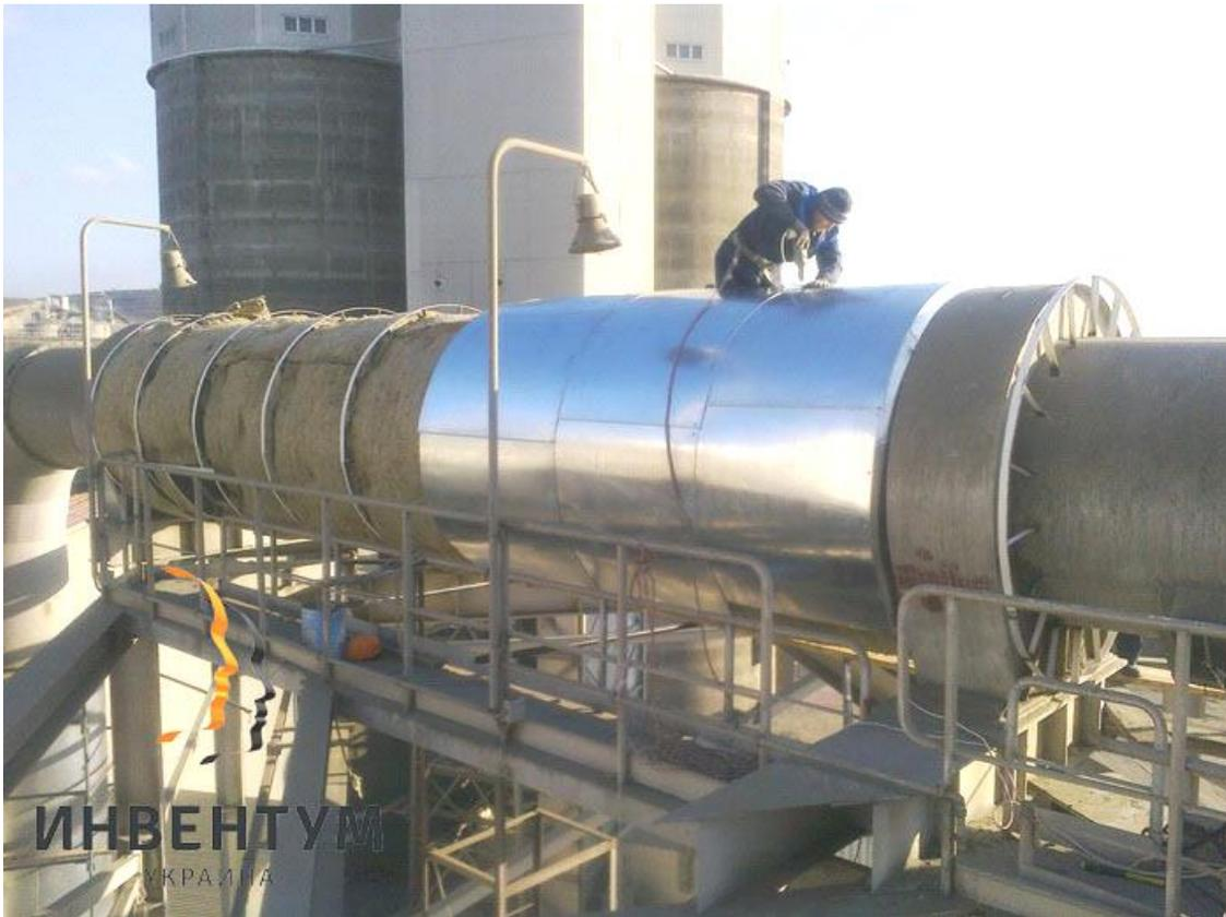
*Рис. 16.2. Тепловая изоляция трубопровода*
