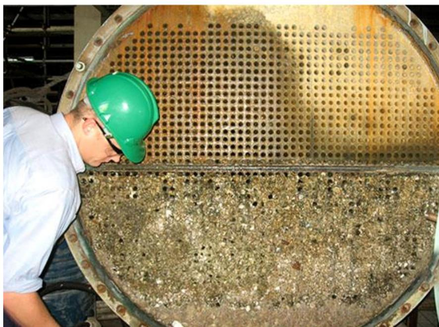
*Рис. 7.4.* Трубный пучок в процессе чистки
